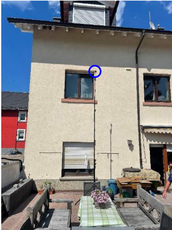
Ansicht aus Südwesten
