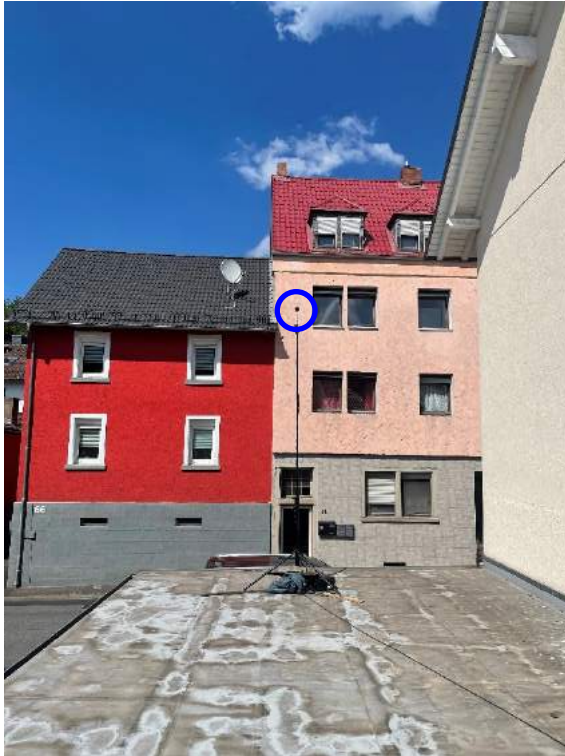
Ansicht aus Südwesten
